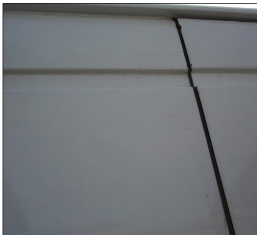
Obr. 52 Horní hrana otvoru bočních dveří 87
