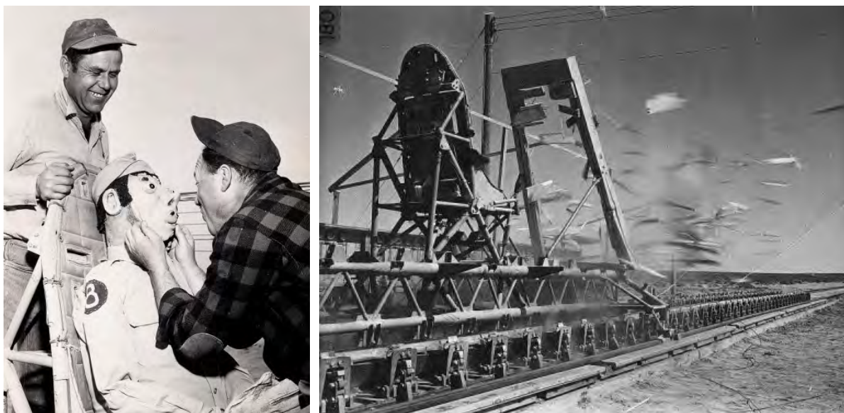
Obr. 3.27 - Příprava figuríny Oskar a fáze brzdění na lineárním zpomalovači 72
